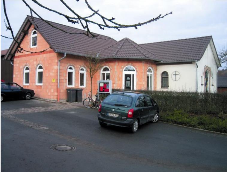
Gemeindehaus An- und Umbau 2004
