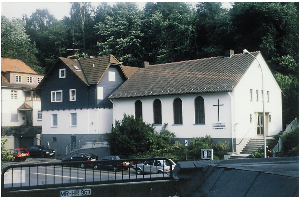
Die beiden Gemeindehäuser in Frankenberg (1992)
