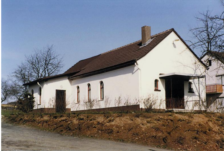
Gemeindehaus mit Anbau 1982
